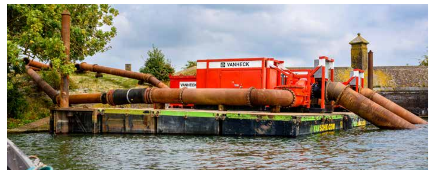
In opdracht van het waterschap heeft Van Heck in 2018 in allerijl een noodinstallatie geplaatst om water vanuit het Markermeer het gebied in te pompen om verzilting tegen te gaan.
